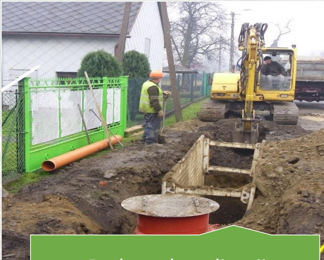
Budowa kanalizacji sanitarnej w Kalnej
