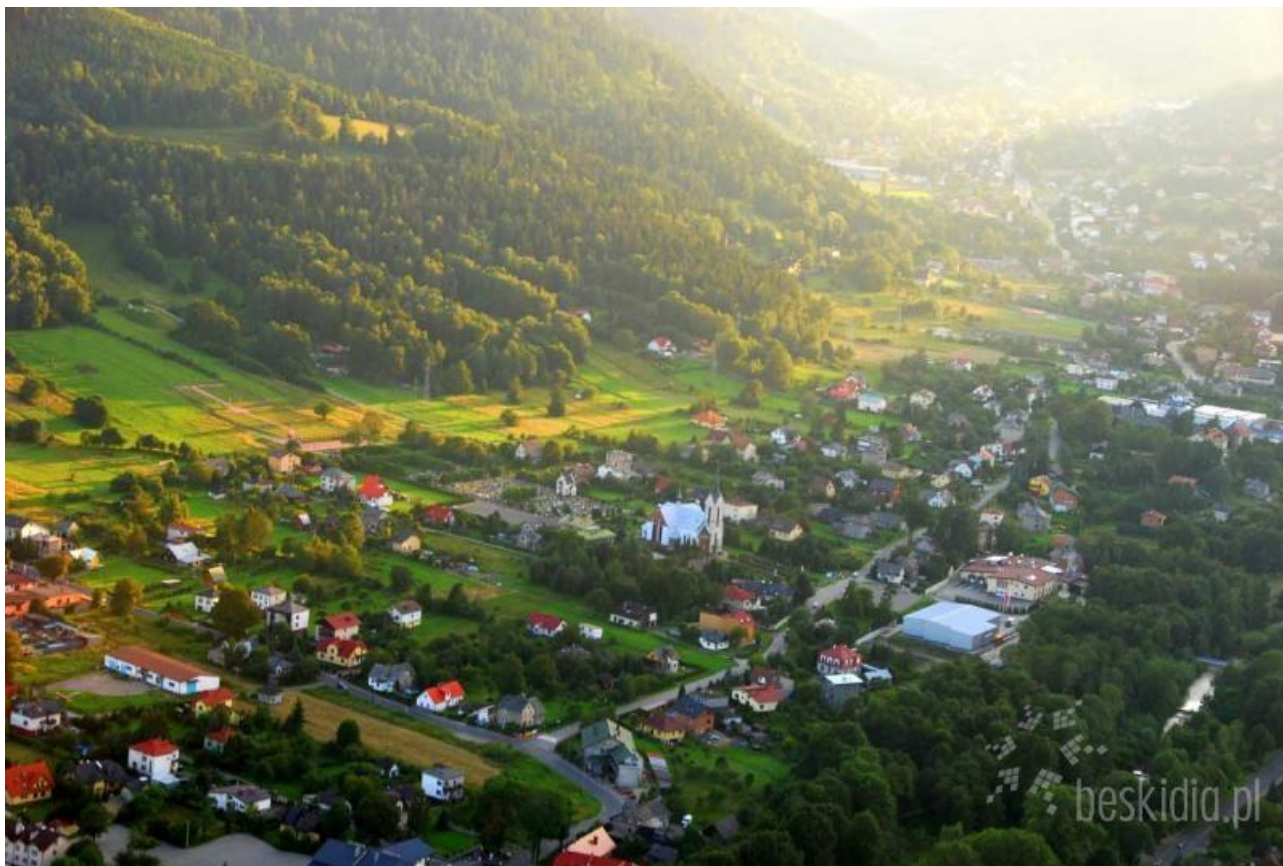
Fot.13. Widok Buczkowic w rejonie kościoła
