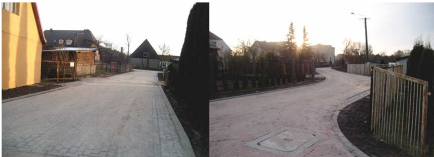
Łęczyce – ul. Kostrzewy – utwardzenie nawierzchni w kostce brukowej
