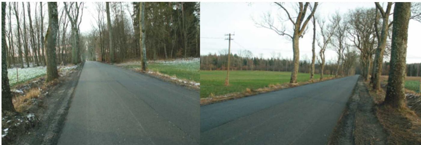
Nowa nawierzchnia mineralno - bitumiczna na drodze powiatowej Łębork - Żelazno na odcinku Kisewo – Brzeźno Łęborskie
