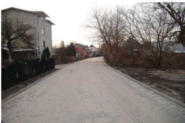
Łęczyce – ul. Kostrzewy - – utwardzenie nawierzchni w kostce brukowej
