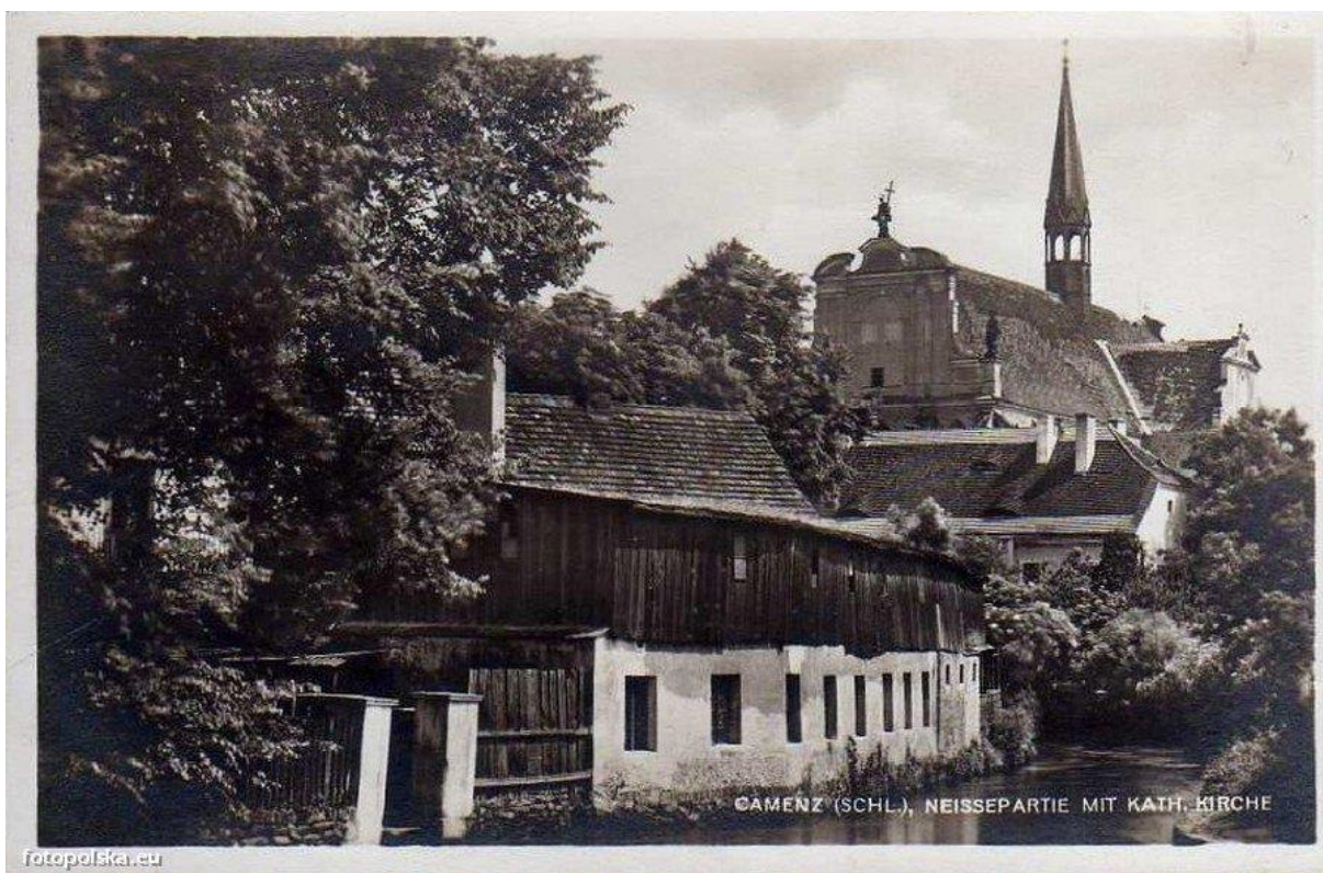
144. Widok klasztoru od zachodu, koryto Młynówki Klasztornej na wysokości wodopoju dla bydła. Camenz (Schl.), Neissepartie mit Kath. Kirche . Poczтівka ok. 1920. www.fotopolska.eu
