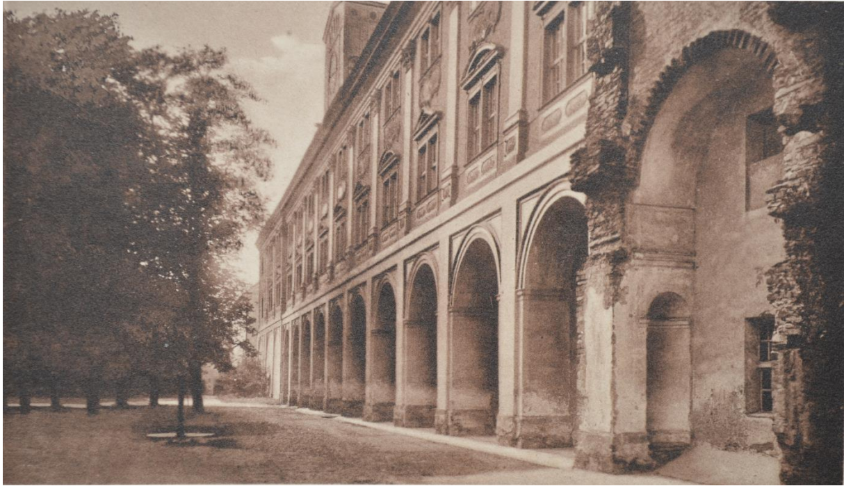
125. Skrzydło pd.-wsch. klasztoru. Pocztówka, fot. P. Skobel, wyd. A. Schatz Camenz. Zbiory prywatne. To samo M. Gaworski, Pałac w Kamieńcu Ząbkowickim... , Strzelce Opolskie 2009, s. 28 z podpisem u dołu Camenz (Schles). Klosterplatz.
