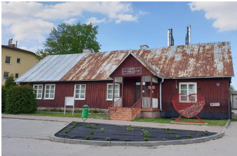
Widok Gminnej Biblioteki Publicznej w Wieniawie przed modernizacją budynku
