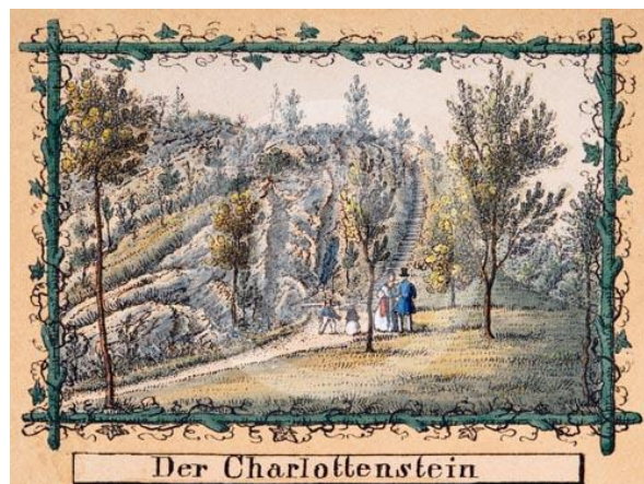
Der Charlottenstein. (Kamień Charlotty)
