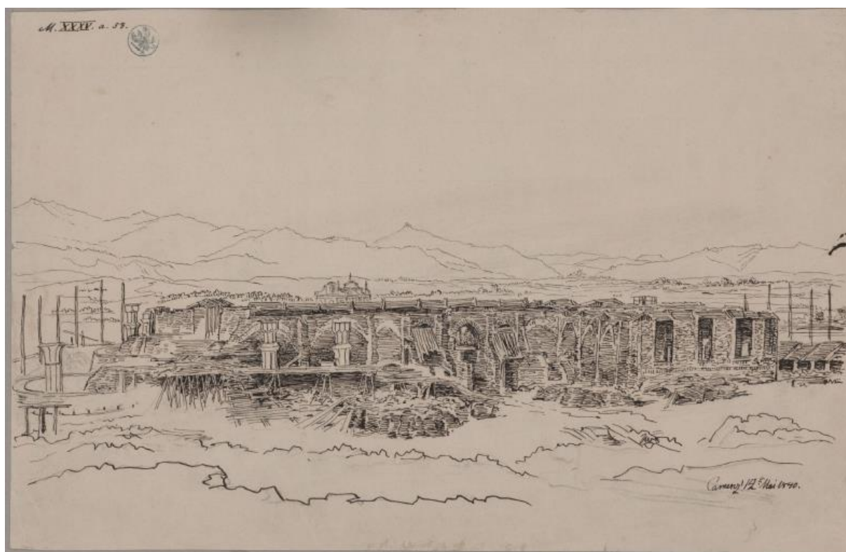
88. Zamek w trakcie budowy, widok od wsch., na drugim planie zarys dachu kościoła klasztornego. Camenz 12.Mai.1840 . Rys. K. F. Schinkel. Staatliche Museen zu Berlin, Kupferstichkabinett , sygn. SM 35a.58. Repr. rys. w G. Grundmann Karl Friedrich Schinkel, Schlesien , Berlin 1941, il. 51, s. 71.
