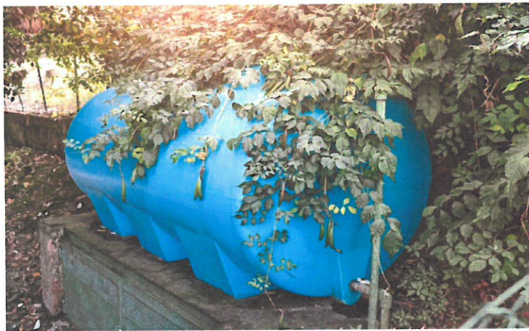
4. Zbiornik na deszczówkę z zestawem solarnym do pompowania wody szarej,
