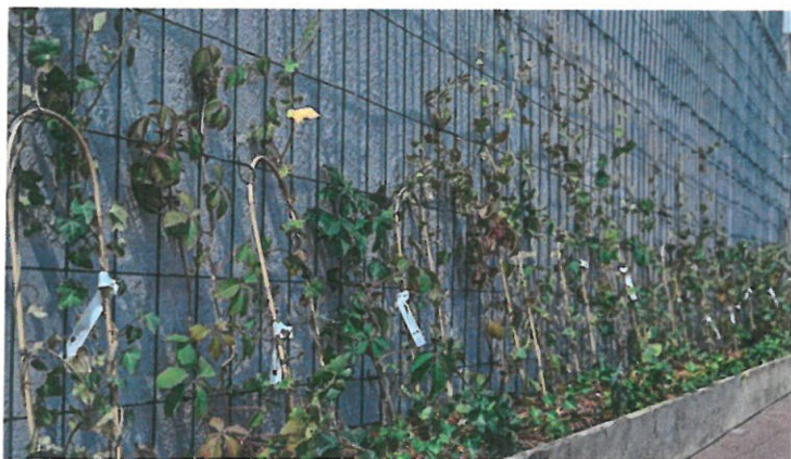
2. Zielona ściana na konstrukcji betonowo stalowej,
