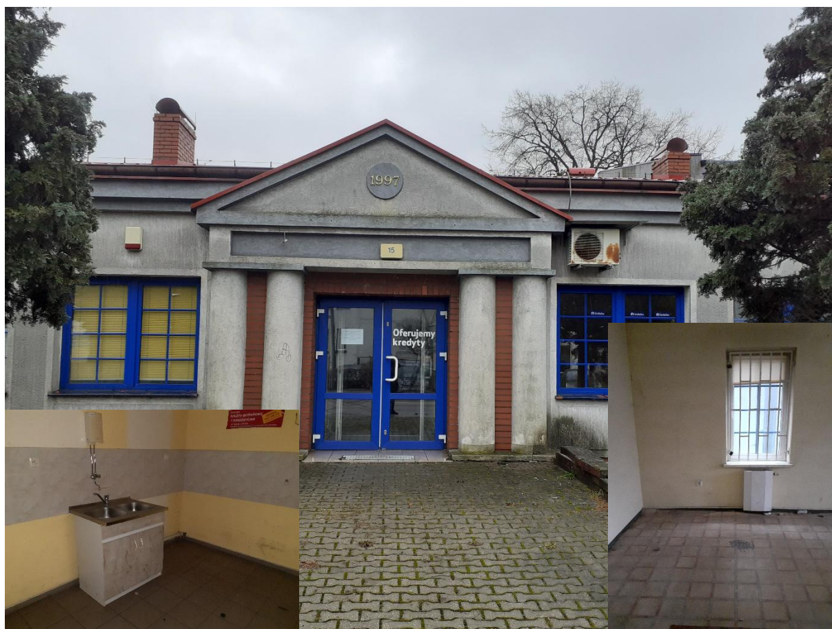
Rycina 25. Stan techniczny budynku przy ul. Jana Pawła II 15
