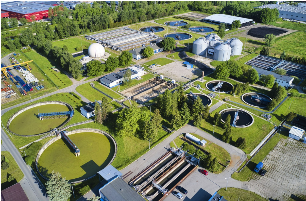
Rysunek 20. Oczyszczalnia ścieków w Komorowicach
