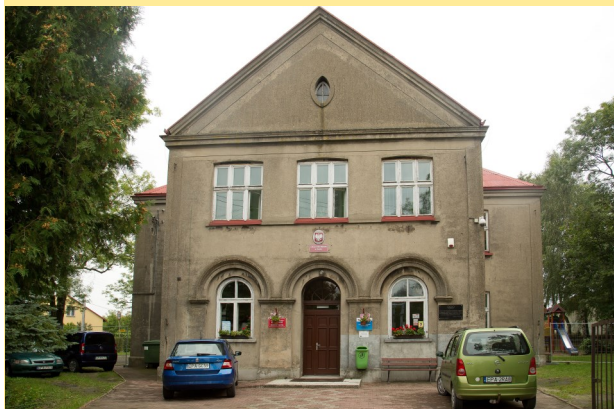
W trakcie prac
