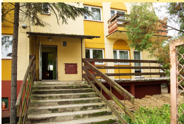
W trakcie prac
