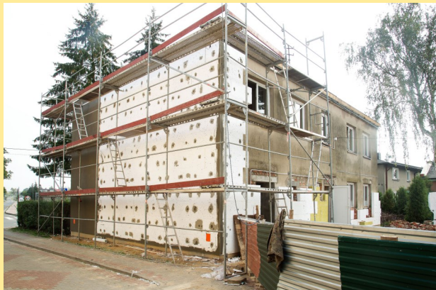
W trakcie prac
