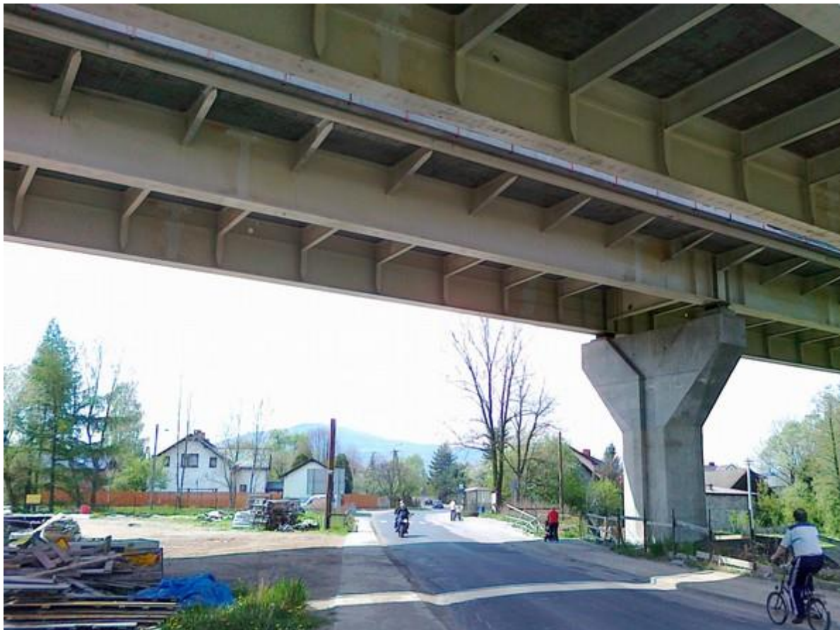
Fot.16. Estakada drogi ekspresowej S-69 w Rybarzowicach.
