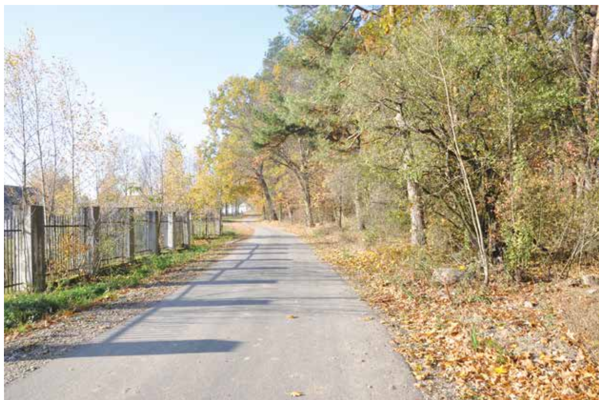
Przebudowa drogi wewnętrznej w miejscowości Ostrowiec
