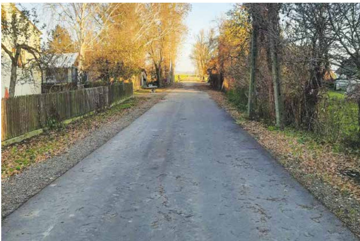
Przebudowa drogi wewnętrznej w miejscowości Wyróżby-Konaty
