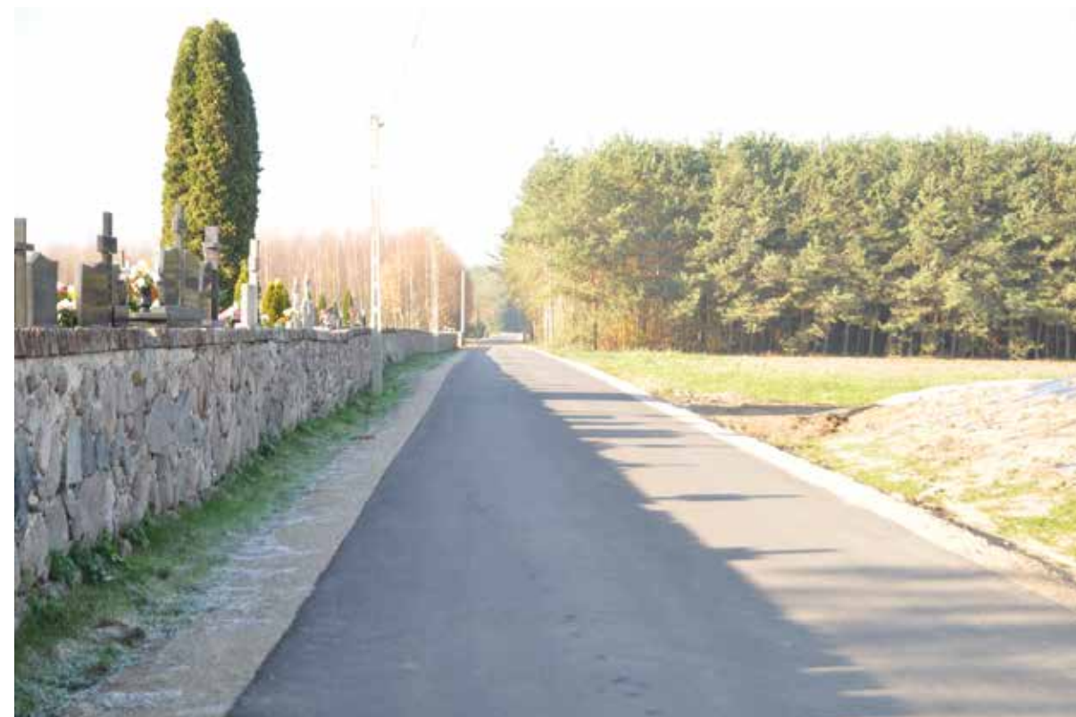
Przebudowa drogi wewnętrznej w miejscowości Skrzyszew
