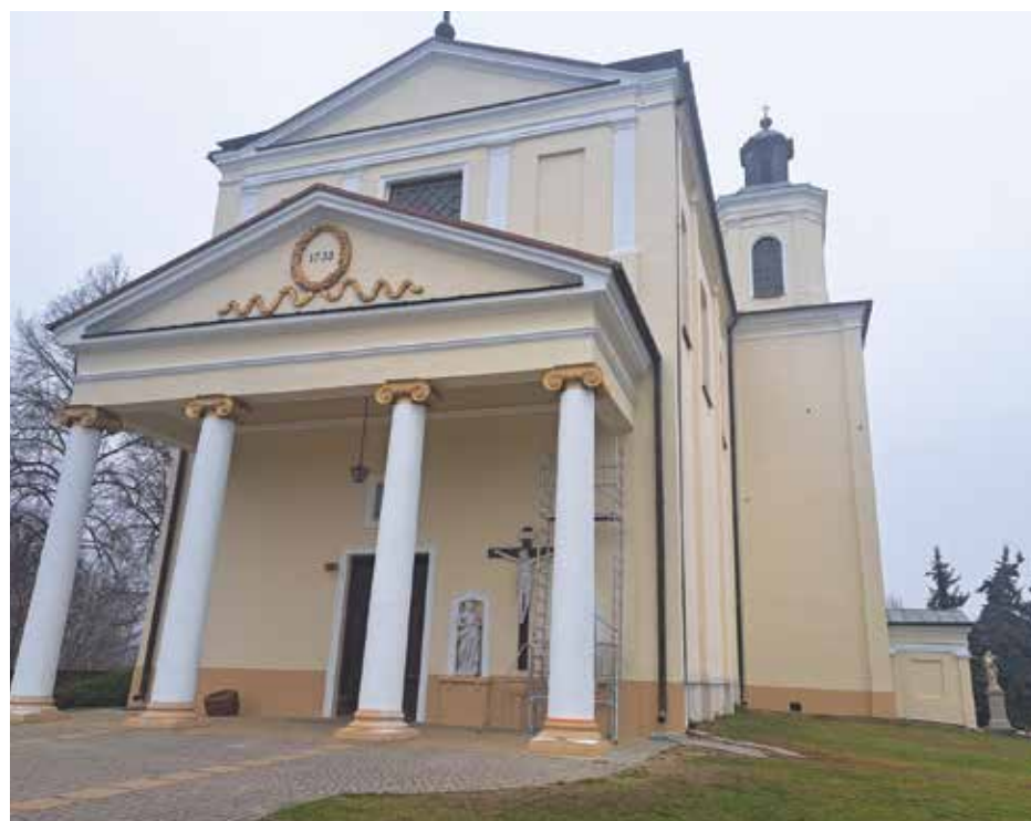
Remont wieży kościoła pw. św. Stanisława Biskupa i Męczennika w Skrzyszewie
