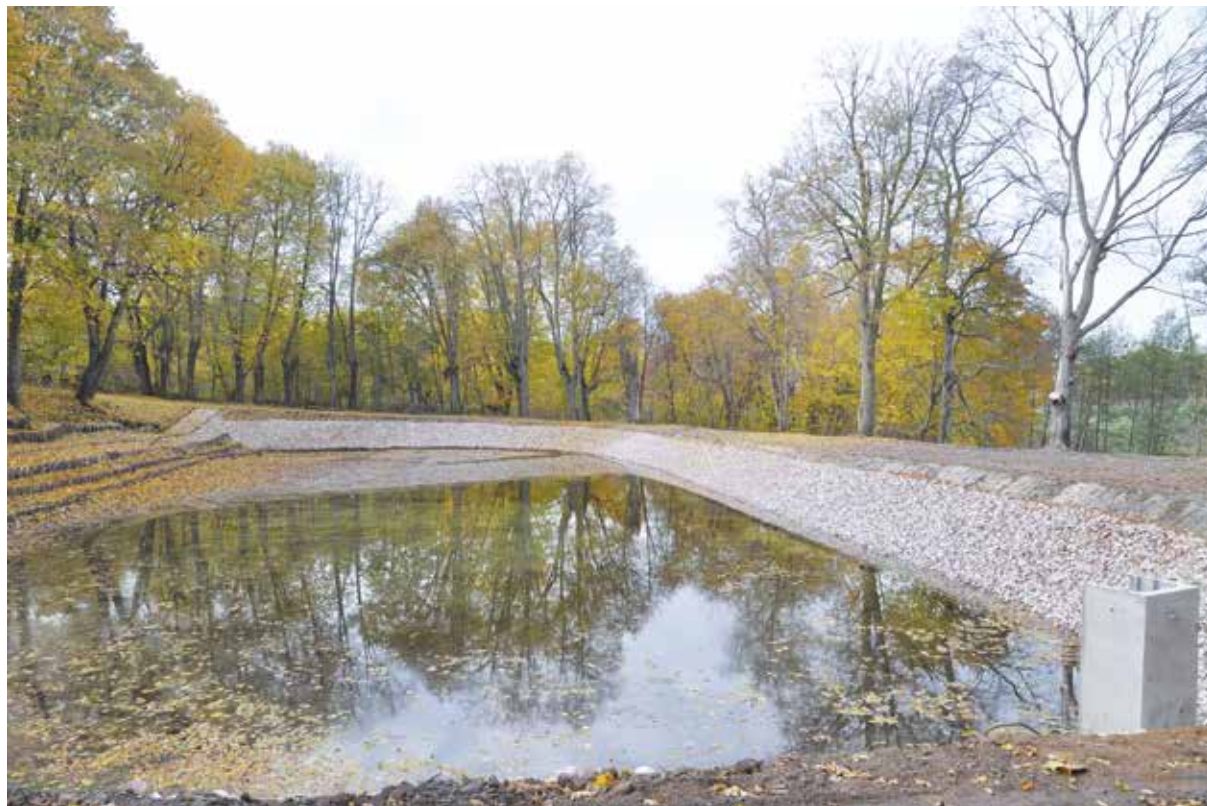
Oczyszczenie zbiornika wodnego w miejscowości Szkopy
