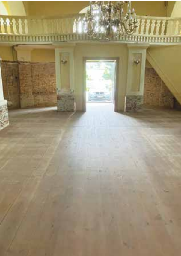
Wymiana podłogi w kościele p.w. Najświętszej Trójcy w Szkopach
