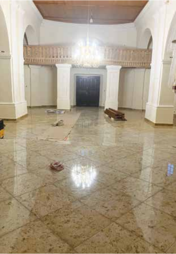
Remont budynku kościoła p.w. Najświętszej Trójcy w Szkopach
