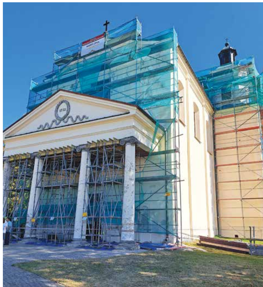
Remont fasady zabytkowego kościoła parafialnego p.w. św. Stanisława Biskupa i Męczennika w Skrzyszewie
