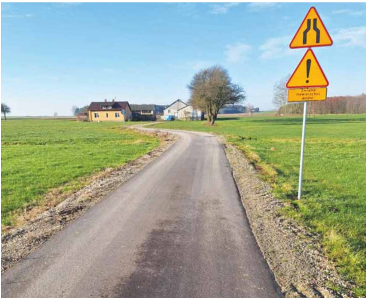
Przebudowa drogi wewnętrznej w miejscowości Sawice-Wieś
