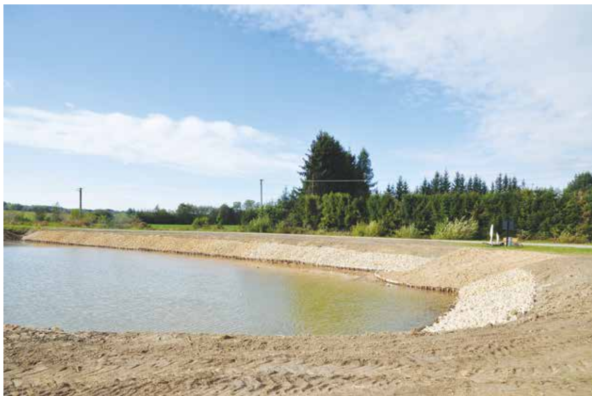
Oczyszczenie zbiornika wodnego w miejscowości Rogów
