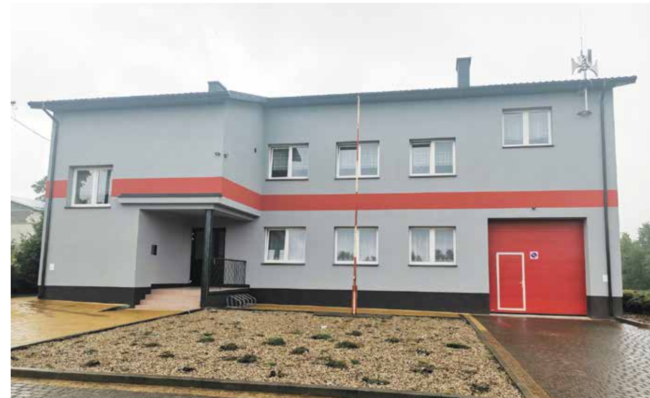
Modernizacja budynku świetlicy wiejskiej w Rogowie
