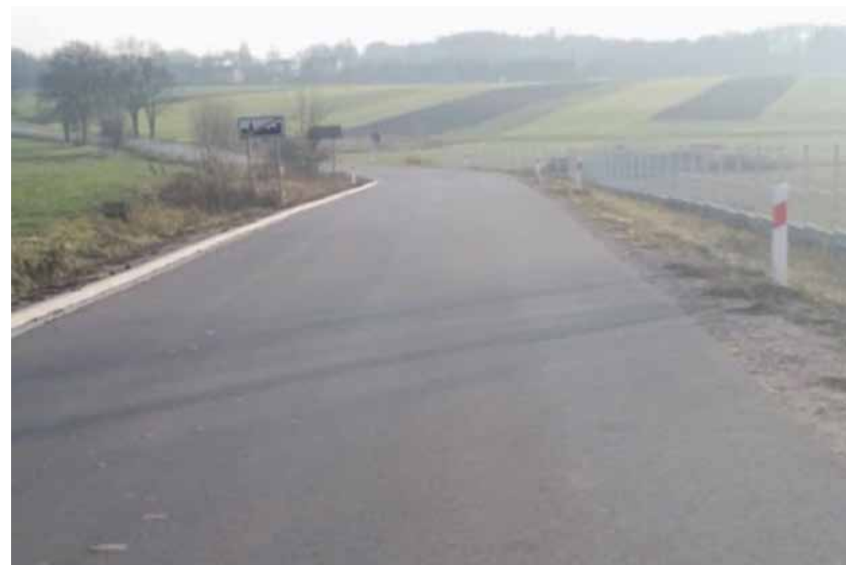
Przebudowa drogi gminnej nr 390504W w miejscowości Sawice-Wieś
