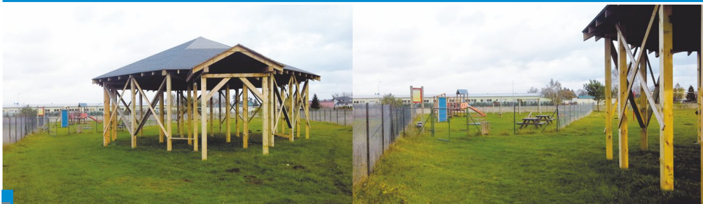
Zagospodarowano plac pod teren rekreacyjny poprzez rozpoczęcie budowy konstrukcji wiaty ogólnoużytkowej oraz wykonano plac zabaw.
