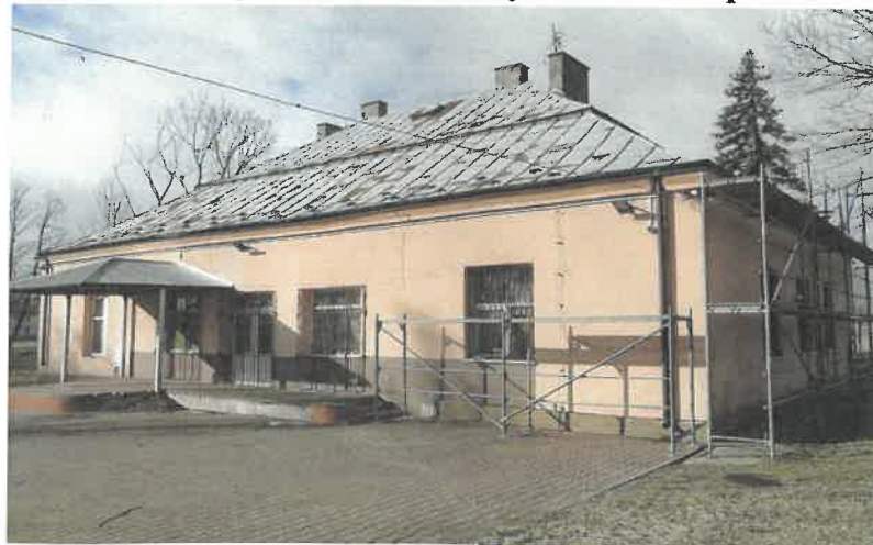
Widok Gminnego Ośrodka Kultury w Wieniawie przed modernizacją budynku
