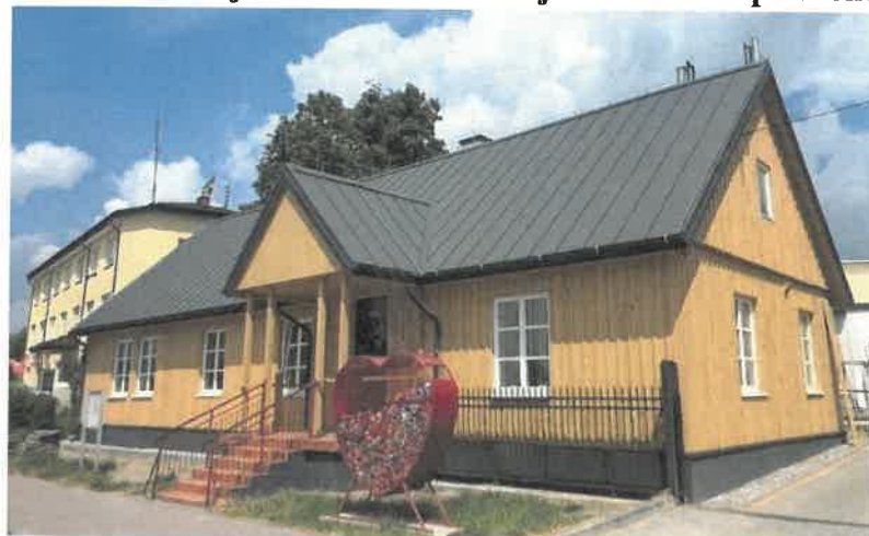
Widok Gminnej Biblioteki Publicznej w Wieniawie po skończonych pracach
