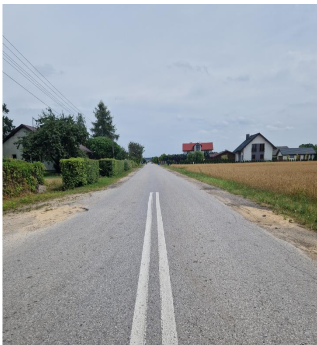
Zdjęcie terenu nr 1 (źródło: wykonanie własne)
