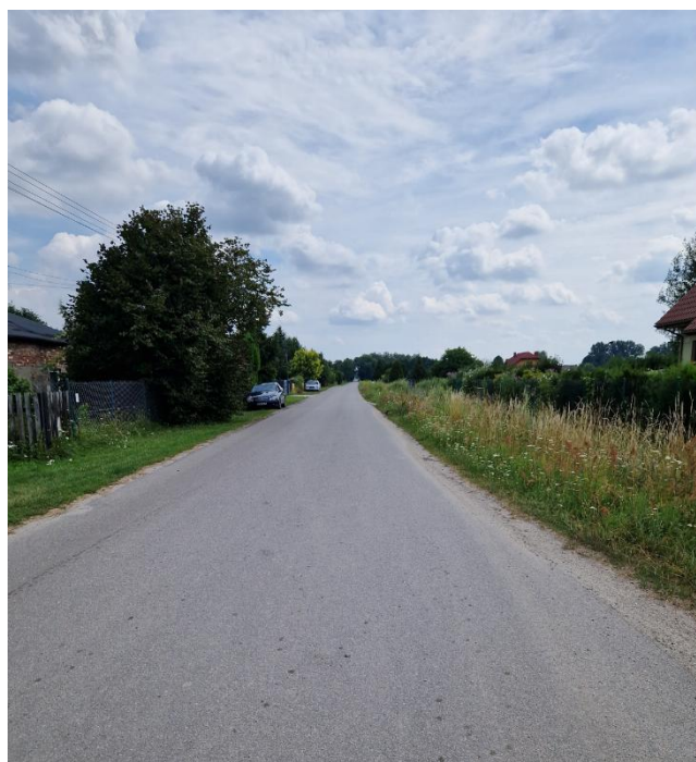
Zdjęcie terenu nr 2 (źródło: wykonanie własne)
