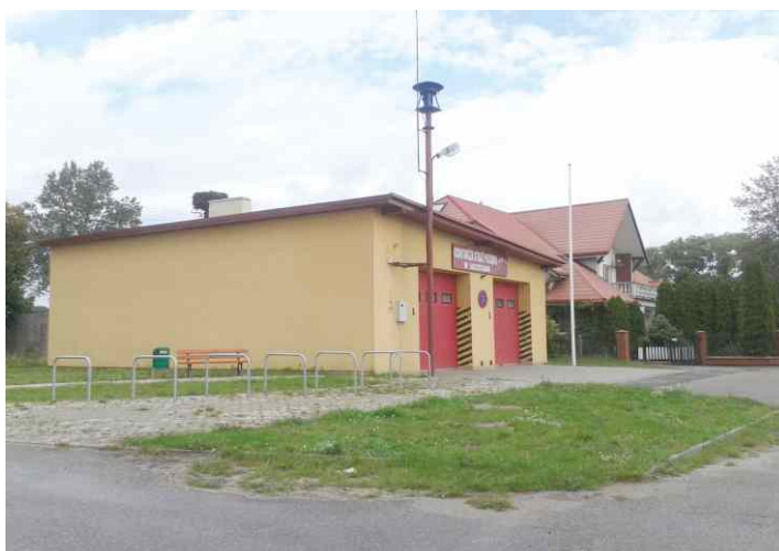
remiza po wyburzeniu świetlicy wiejskiej
