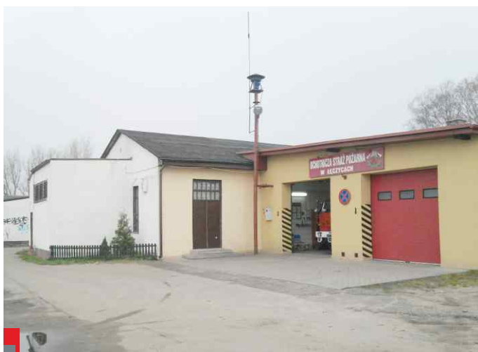
remiza wraz z świetlicą wiejską
