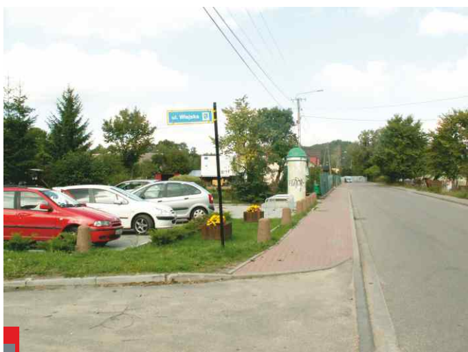
wykonanie parkingu przy OPS-ie
