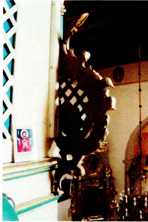
Odwrocie uszaka po lewej stronie szafy organowej. W jego dolnej partii widoczne zacieki białej farby. Na odwrociu widoczne stosunkowo nieliczne otwory wylotowe świadczące o bytowaniu drewnojadów. .
