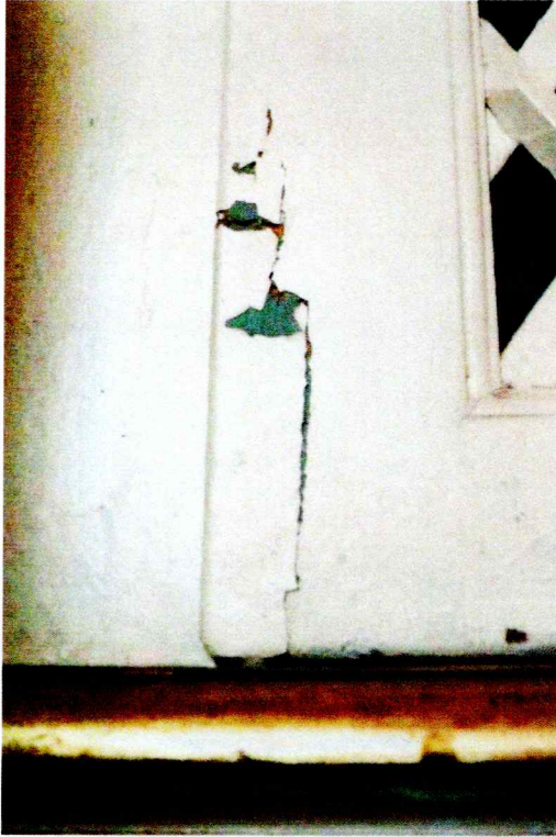
W odpryskach białej farby widoczna wcześniejsza, zielonkawa wyprawa malarska – w tonacji zbliżona do zielonych partii gzymsów pomiędzy połączanymi profilami
