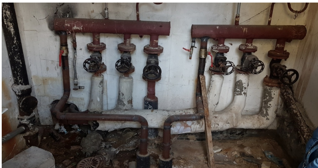
Fot. 5 Rozdzielacz w pomieszczeniu węzła ciepłowniczego budynku Przedszkola i NZOZ-u
