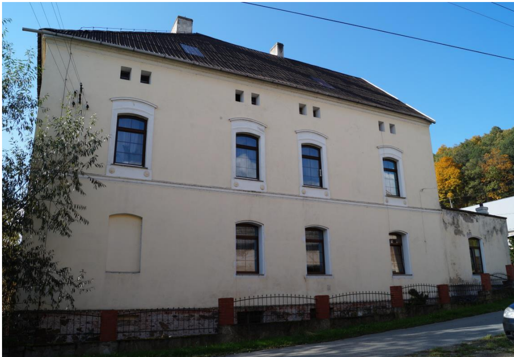
Budynek mieszkalno-administracyjny w zespole budynków młyna wodnego
