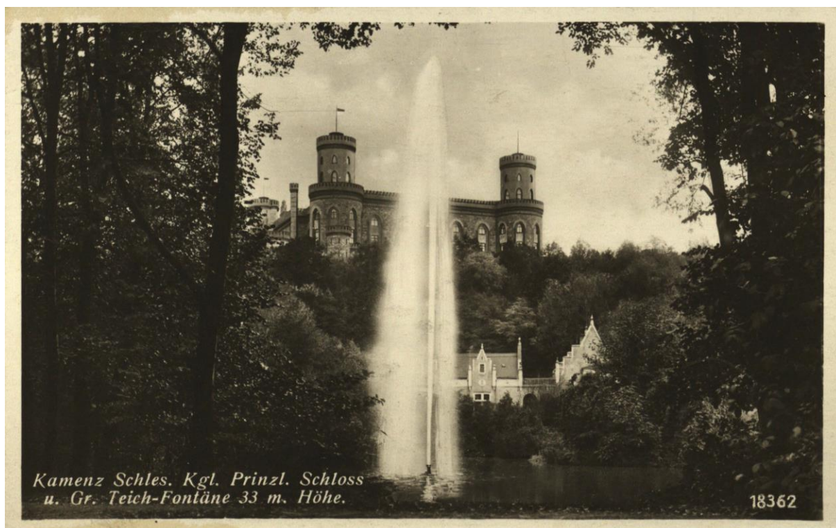
256. Widok od pd.-wsch. na budynek elektrowni i przepompowni oraz fontannę na stawie. Kamenz Schles. Kgl. Prinzl. Schloss u. Gr. Teich-Fontanne 33 m. Höhe. Karta pocztowa. BUWr OZG sygn.
