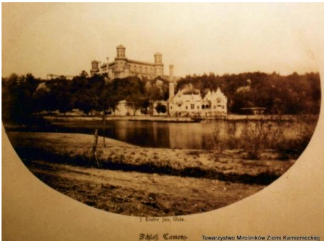
248. Widok od południa na staw, budynek przepompowni i pałac. Schloß Camenz . Fot. ok. 1865. Towarzystwo Miłośników Ziemi Kamienieckiej.
