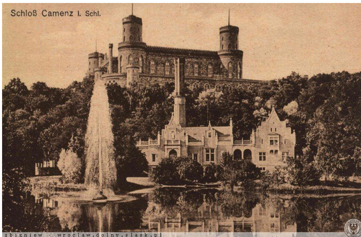
264. Widok od pd.-wsch. na budynek elektrowni i przepompowni. Schloß Camenz i. Schl. Pocztówka. www.dolnyslask.org.pl
