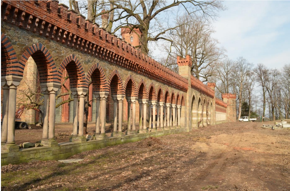
45. Kamieniec Ząbkowicki. Pałac – mur arkadowy od wschodu.
