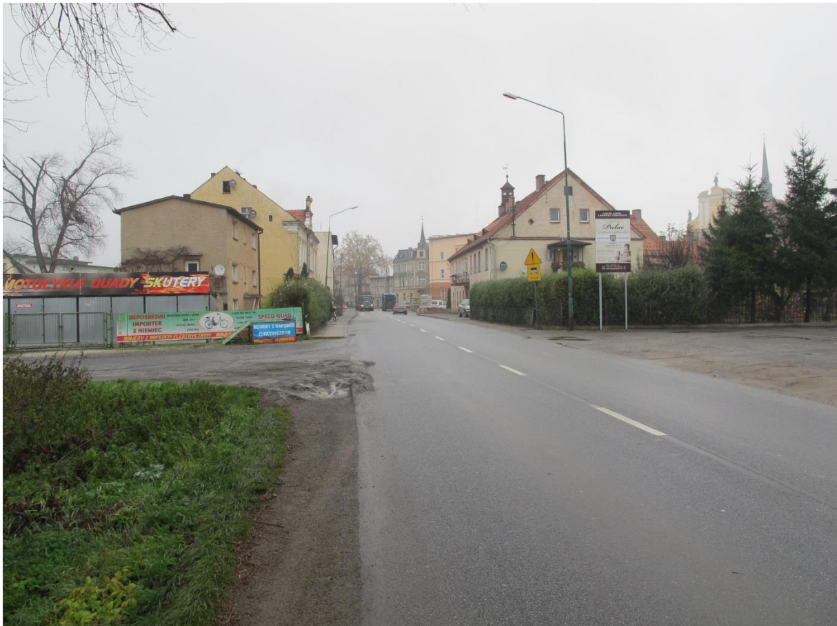
36. Kamieniec Ząbkowicki. Ul. Złotostocka 44. Miejsce dawnego mostu na młynówce klasztornej.
