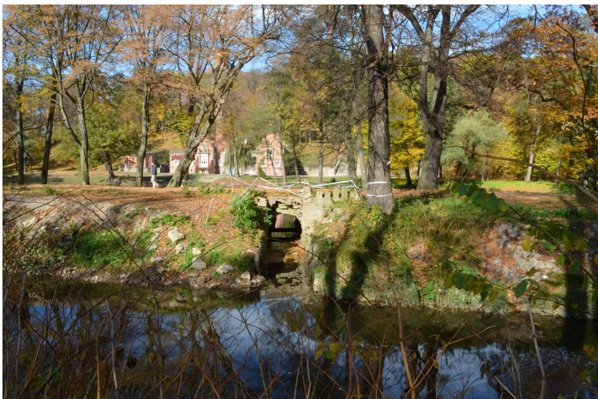
48. Kamieniec Ząbkowicki. Staw maszynowni – ujście do Budzówki.
