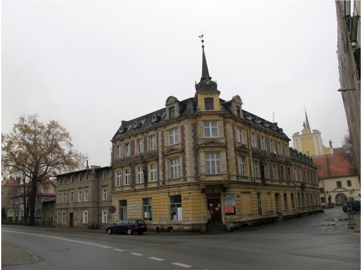
29. Kamieniec Ząbkowicki. Ul. Złotostocka, skrzyżowanie z ul. Kościelną.
