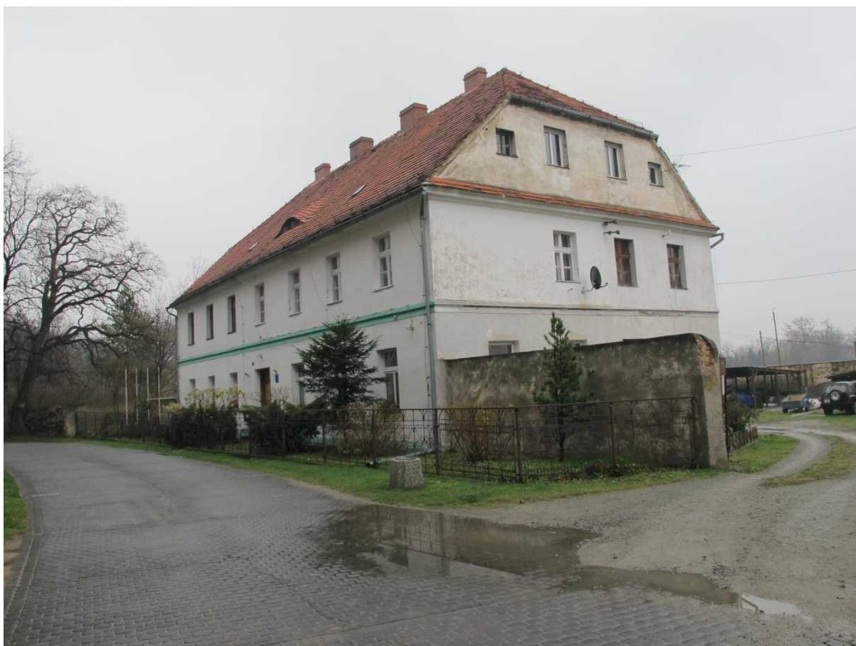
8. Kamieniec Ząbkowicki. Szkoła katolicka, obecnie dom pl. Kościelny 7.
