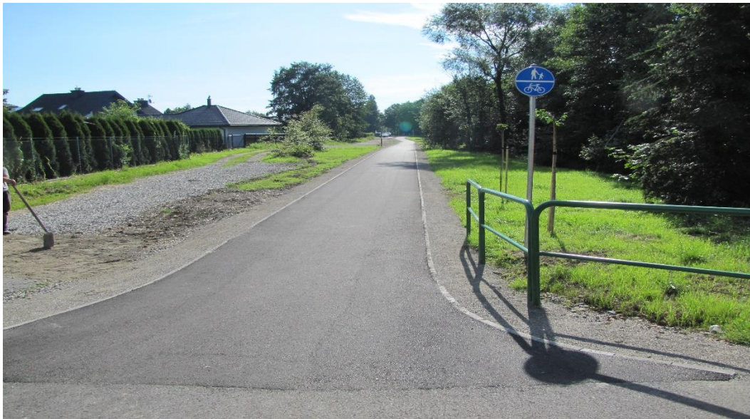
Wybudowana ścieżka w rejonie ul. Kowalskiej
