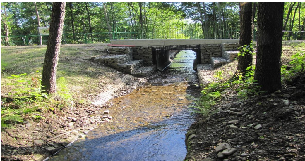
Wybudowany przepust w ciągu ścieżki dydaktycznej
