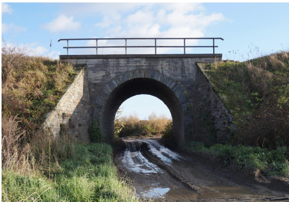
Wiadukt linii kolejowej Wrocław – Międzylesie
