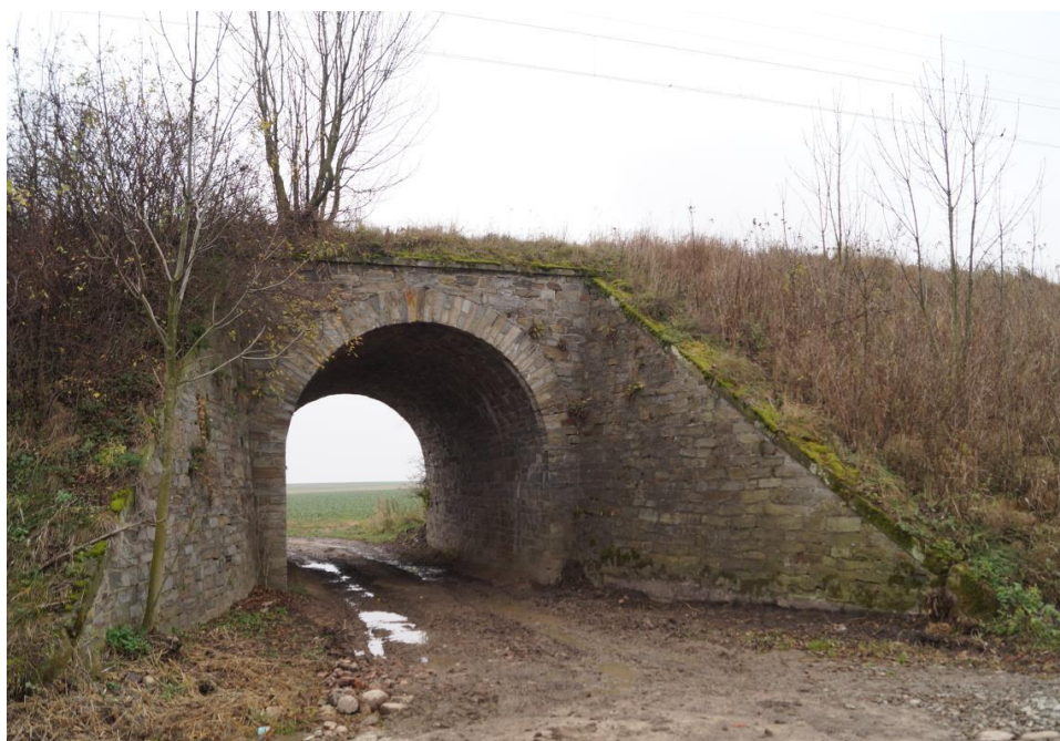
Wiadukt linii kolejowej Wrocław – Międzylesie
