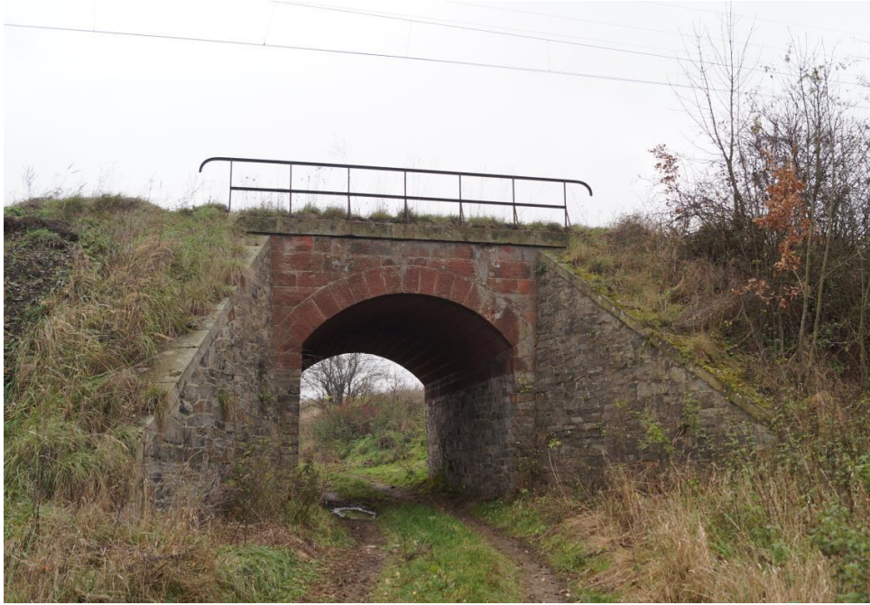
Wiadukt linii kolejowej Wrocław – Międzyzlesie
