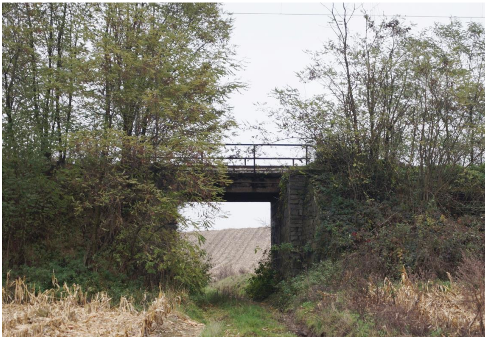
Wiadukt linii kolejowej Wrocław - Międzyzlesie
