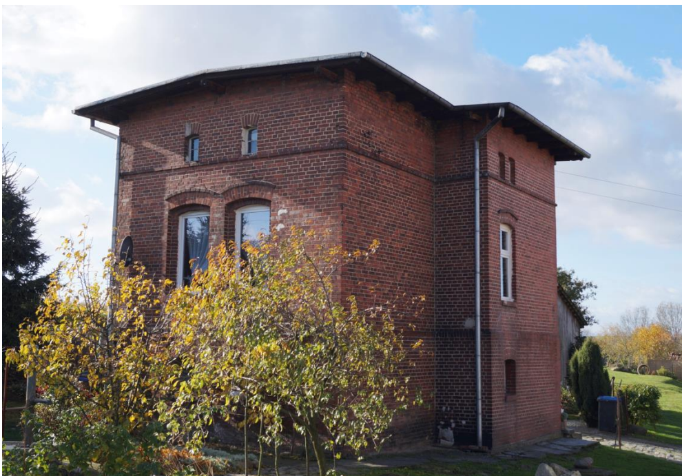
Dom dróżnika przy linii kolejowej Wrocław – Międzylesie
