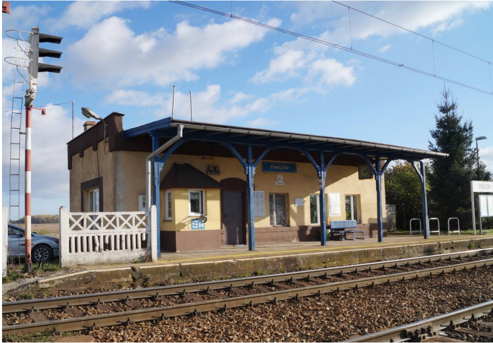
Dworzec kolejowy Starczów przy linii kolejowej Wrocław - Międzylesie
