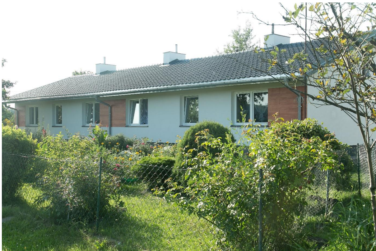
Budynek komunalny Markówka 52
