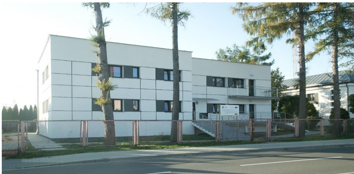
Budynek komunalny Dobroń ul. 11 Listopada 11
