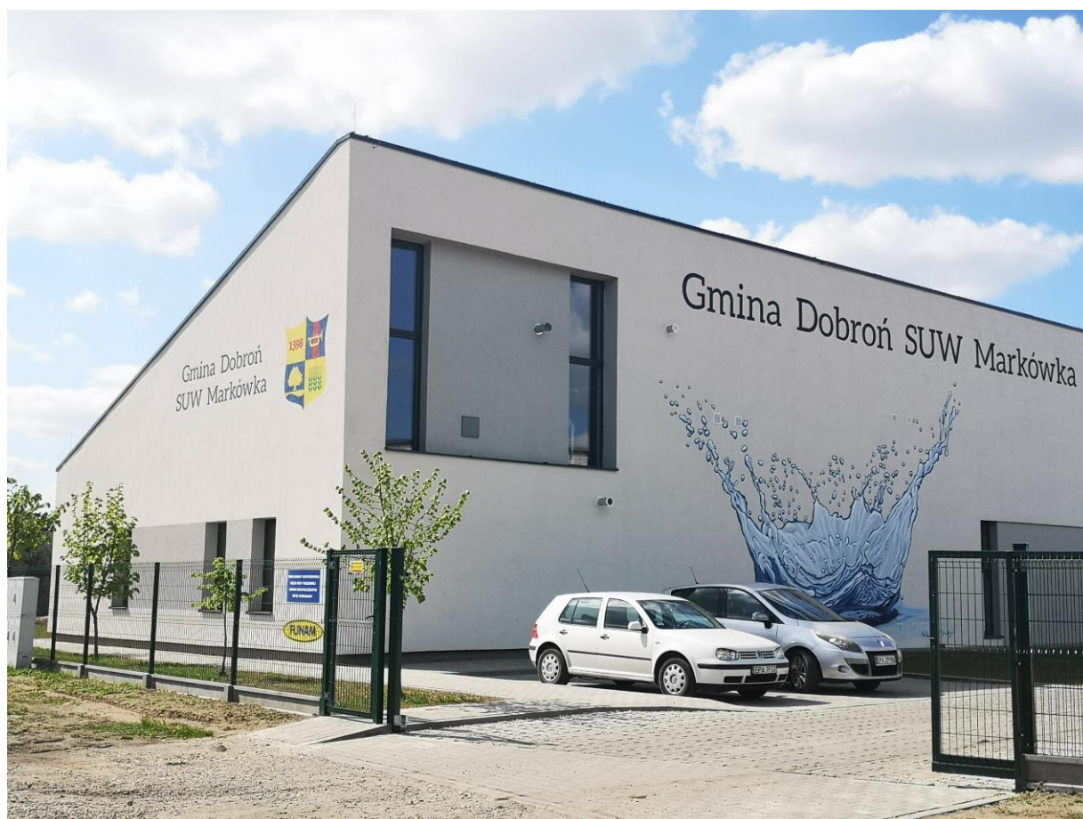
Nowy budynek Stacji Uzdatniania Wody w Markówce
