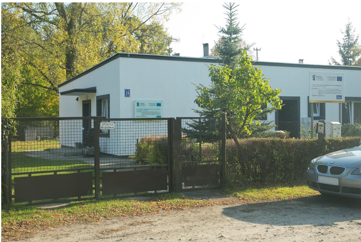
Budynek komunalny Dobroń ul. Sportowa 18
