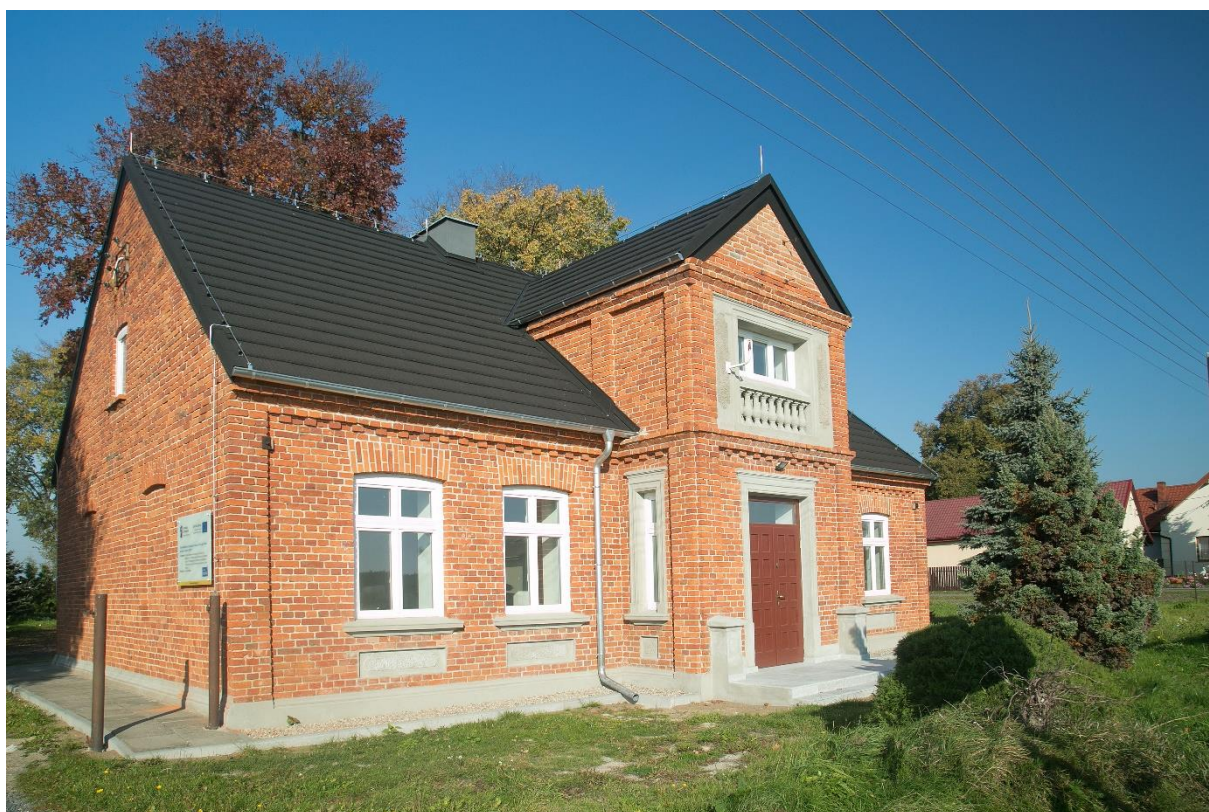
Budynek komunalny Mogilno Duże 14
