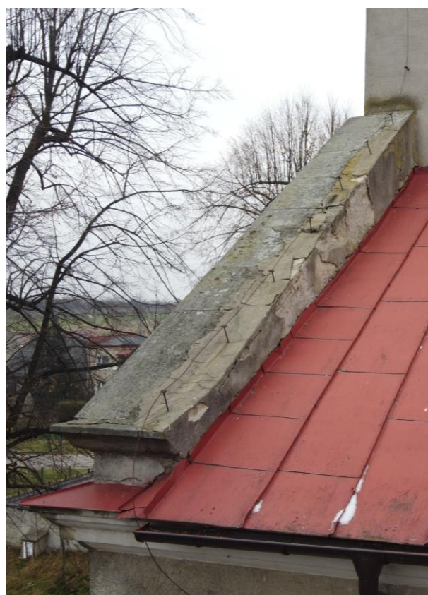
fot. nr 23 – uszkodzenia attyki nawy bocznej
