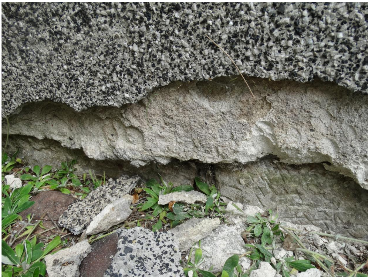
fot. nr 26 – cokół naw bocznych z odsłoniętym układem warstw.
