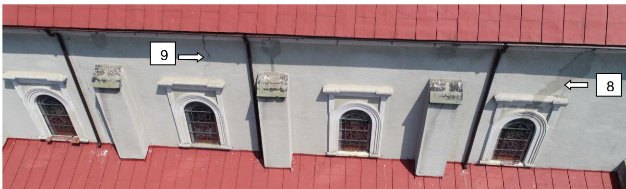
fot. nr 31 – rysy na el. południowej: widoczne i naprawione
