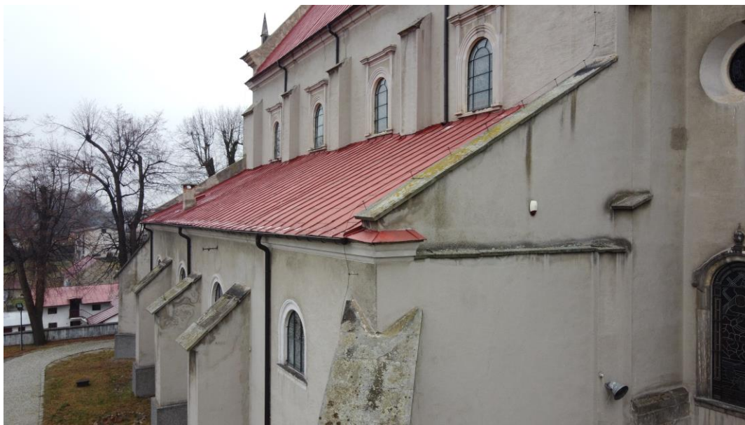
fot. nr 24 – korozja biologiczna na kamiennych zwieńczeniach attyk i przypór
