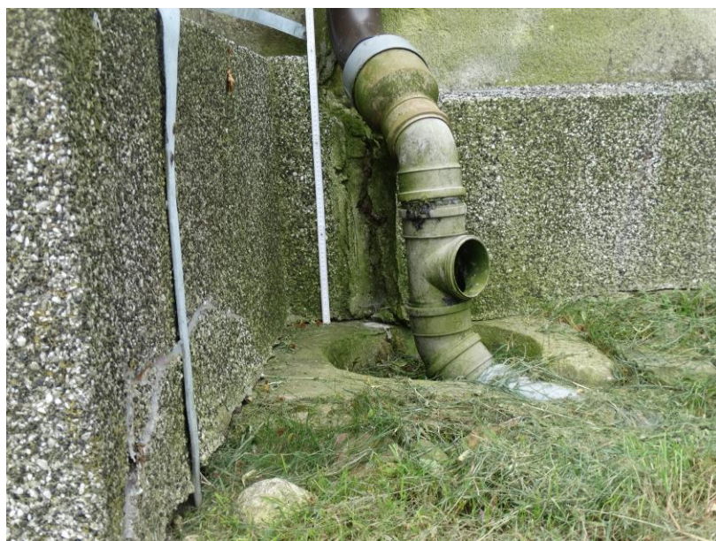
fot. nr 27 – stan wpustów do kanalizacji drenującej.
