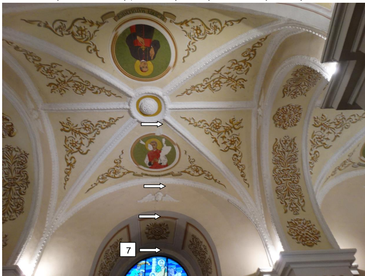
fot. nr 33 – rysa od str. południowej nr 7, od zwornika okna do zwornika sklepienia nawy bocznej.
