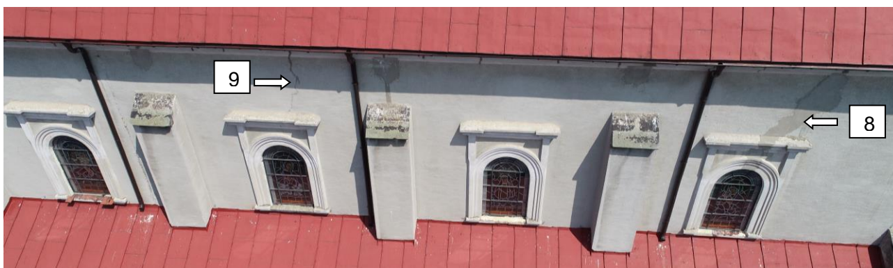
rysy na el. południowej: widoczne i naprawione
