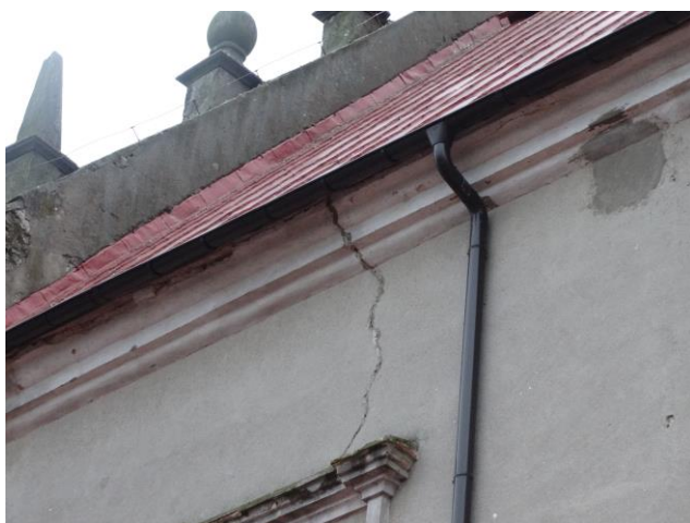
fot. nr 29 – rysa nad kaplicą na el. północnej fot. nr 30 – rysy na el. południowej
