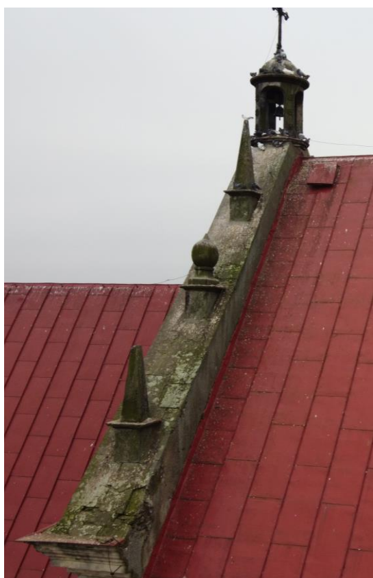
fot. nr 22 - uszkodzenia attyki nawy głównej
