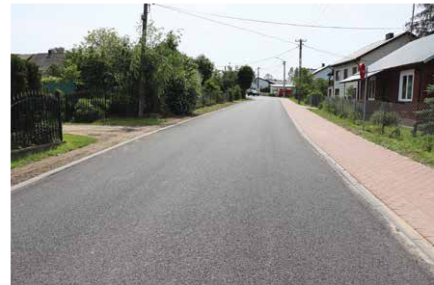
Przebudowa drogi powiatowej w miejscowości Liszki
