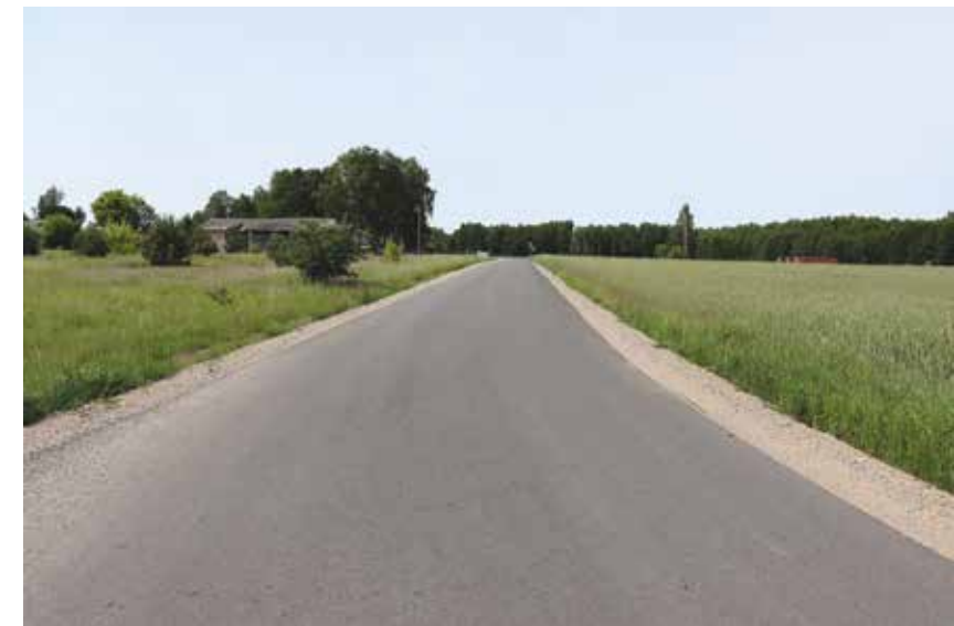
Przebudowa drogi powiatowej na odcinku Karskie - Liszki
