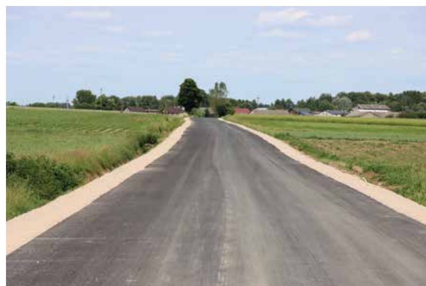
Przebudowa drogi powiatowej w miejscowości Sawice-Wieś
