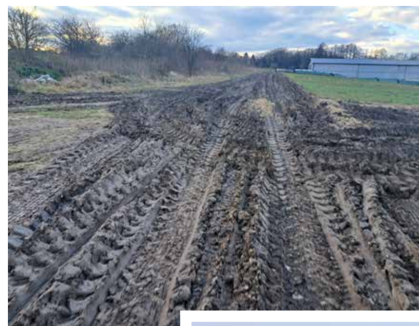
Przebudowa drogi wewnętrznej na odcinku Zawady - Wyrozębny-Konaty
