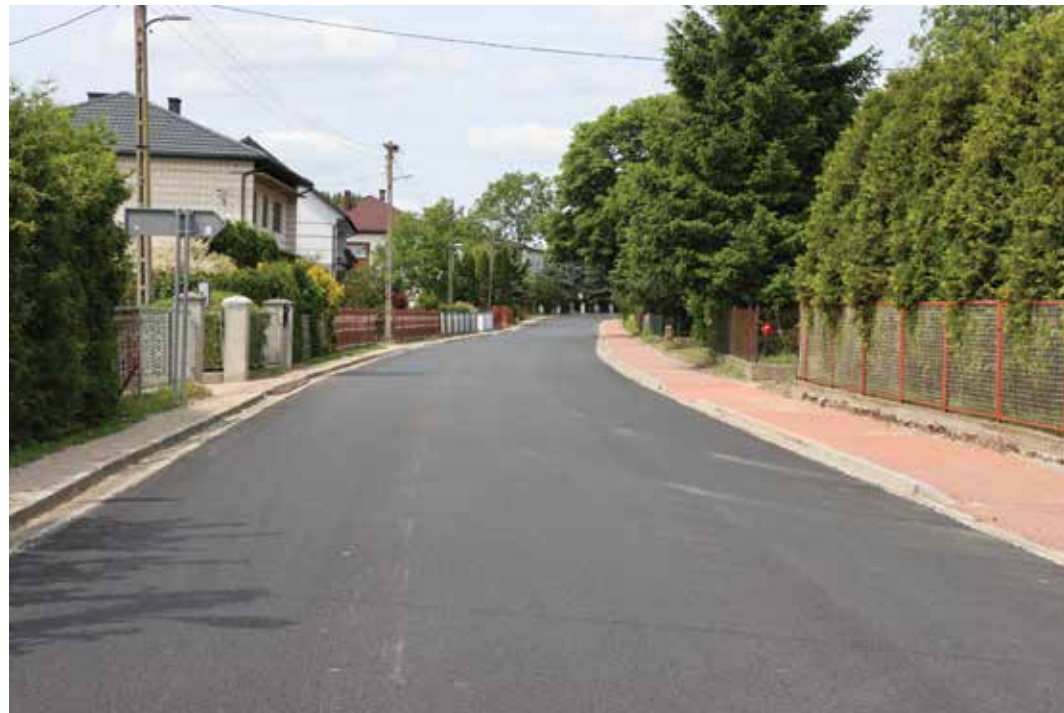
Przebudowa drogi powiatowej w miejscowości Borychów
