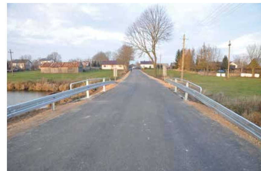
Przebudowa drogi powiatowej na odcinku Repki - Kamianka
