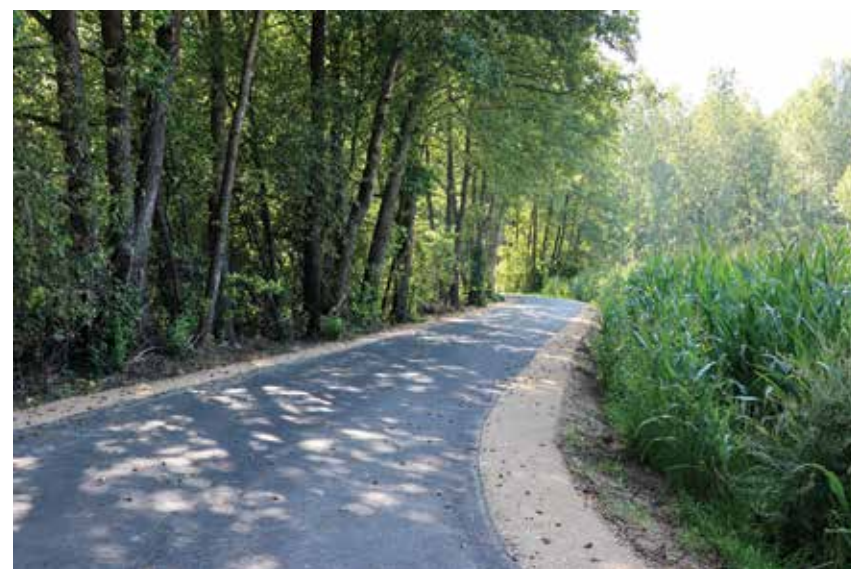
Przebudowa drogi wewnętrznej do miejscowości Karskie
