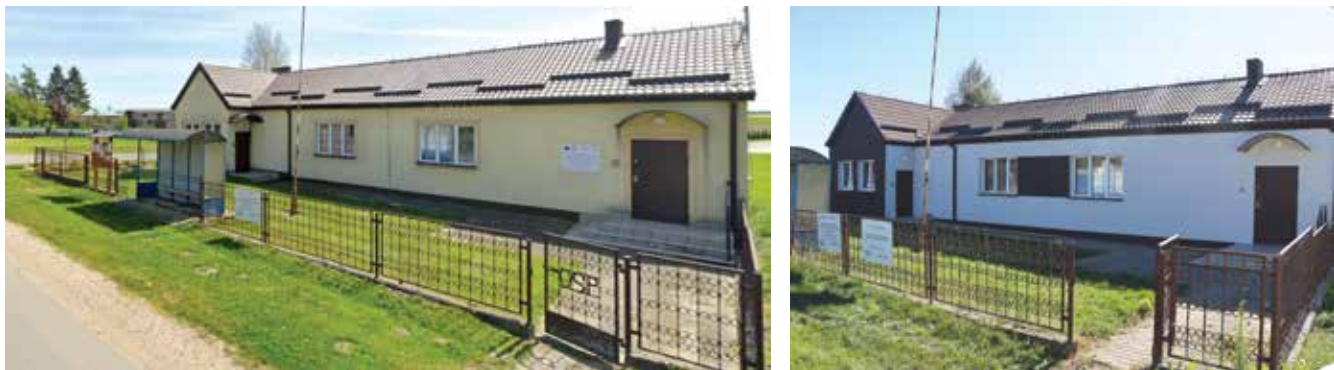
Termomodernizacja budynku świetlicy wiejskiej w miejscowości Skwierczyn-Dwór
