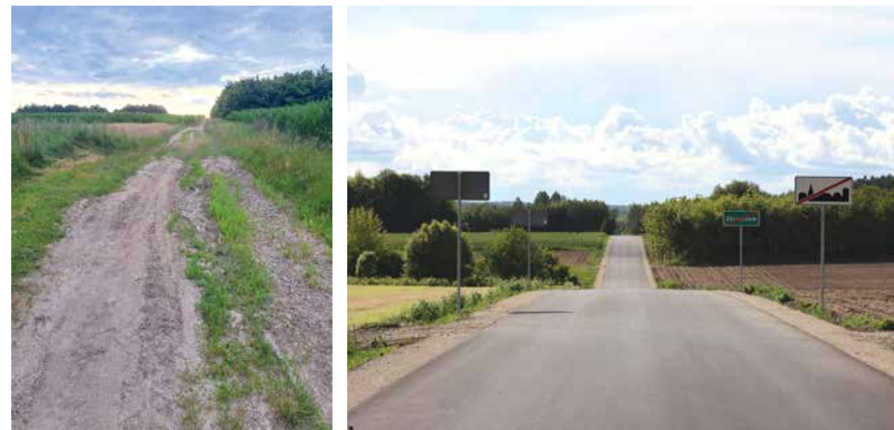
Przebudowa drogi gminnej nr 390523W Skrzyszew-Kanabród
