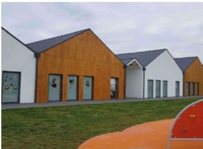
Fot. 1.19 Przedszkole wykonane w technologii prefabrykowanego szkieletu drewnianego, Gdańsk (fot. z archiwum Stowarzyszenia EDG)
