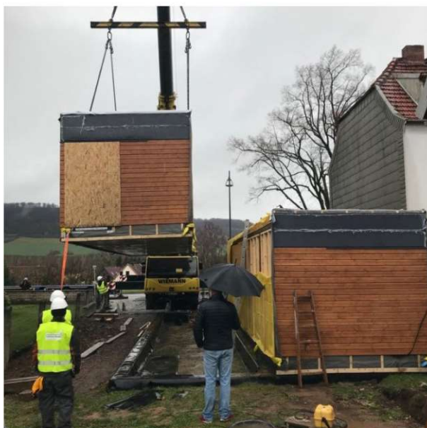
Fot. 1.11 Montaż jednorodzinny budynek modułowy (fot B. Jaworski)
