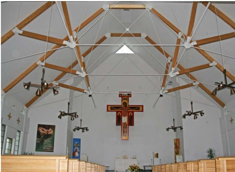
Fot. 1.21 Kościół w Łodzi, rozpiętość 18,5 m (fot. E.I. Kotwica)
