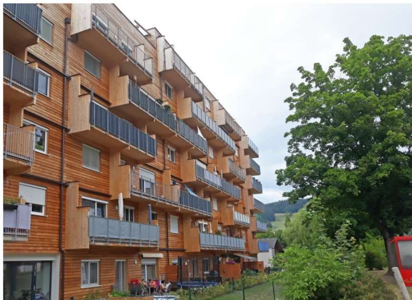
Fot. 1.2. Budynek wielorodzinny w Leoben, Austria (fot. P. Sulik)
