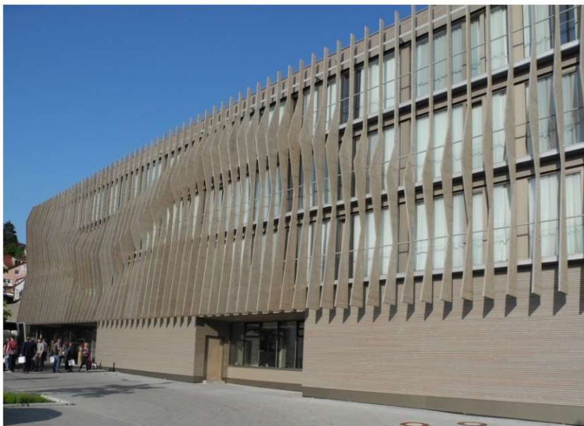
Fot. 1.3. Szkoła o konstrukcji drewnianej w Diedorf, Niemcy (fot. P. Sulik)
