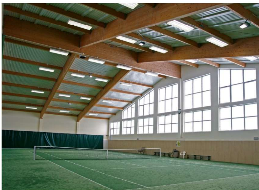
Fot. 1.23 Hala tenisowa w Pruszkowie, rozpiętość 38,8 m (fot. E.I. Kotwica)
