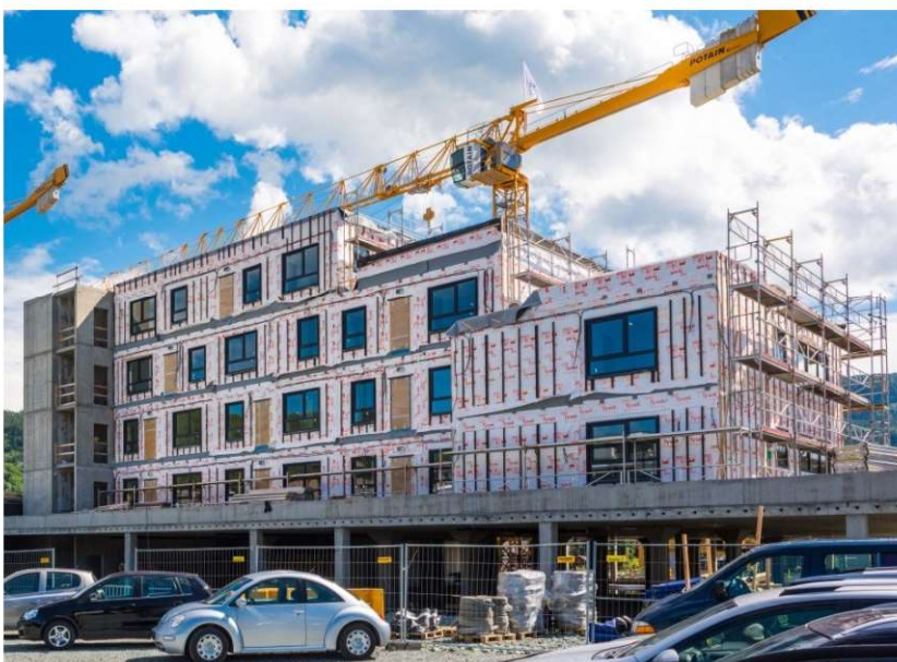
Fot. 1.10 Montaż modułowego budynku wielorodzinnego przez polskiego producenta w Norwegii (fot. Z archiwum Stowarzyszenia Energooszczędne Domy Gotowe)
