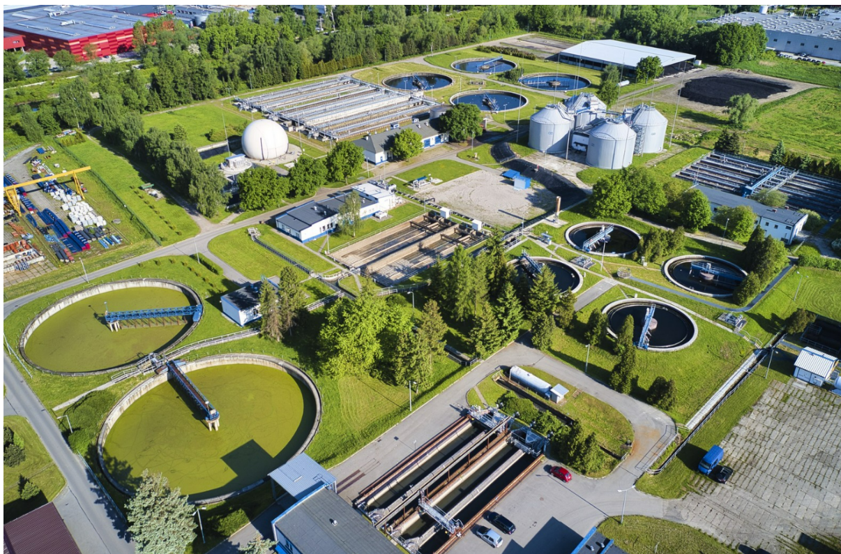
Rysunek 20. Oczyszczalnia ścieków w Komorowicach
