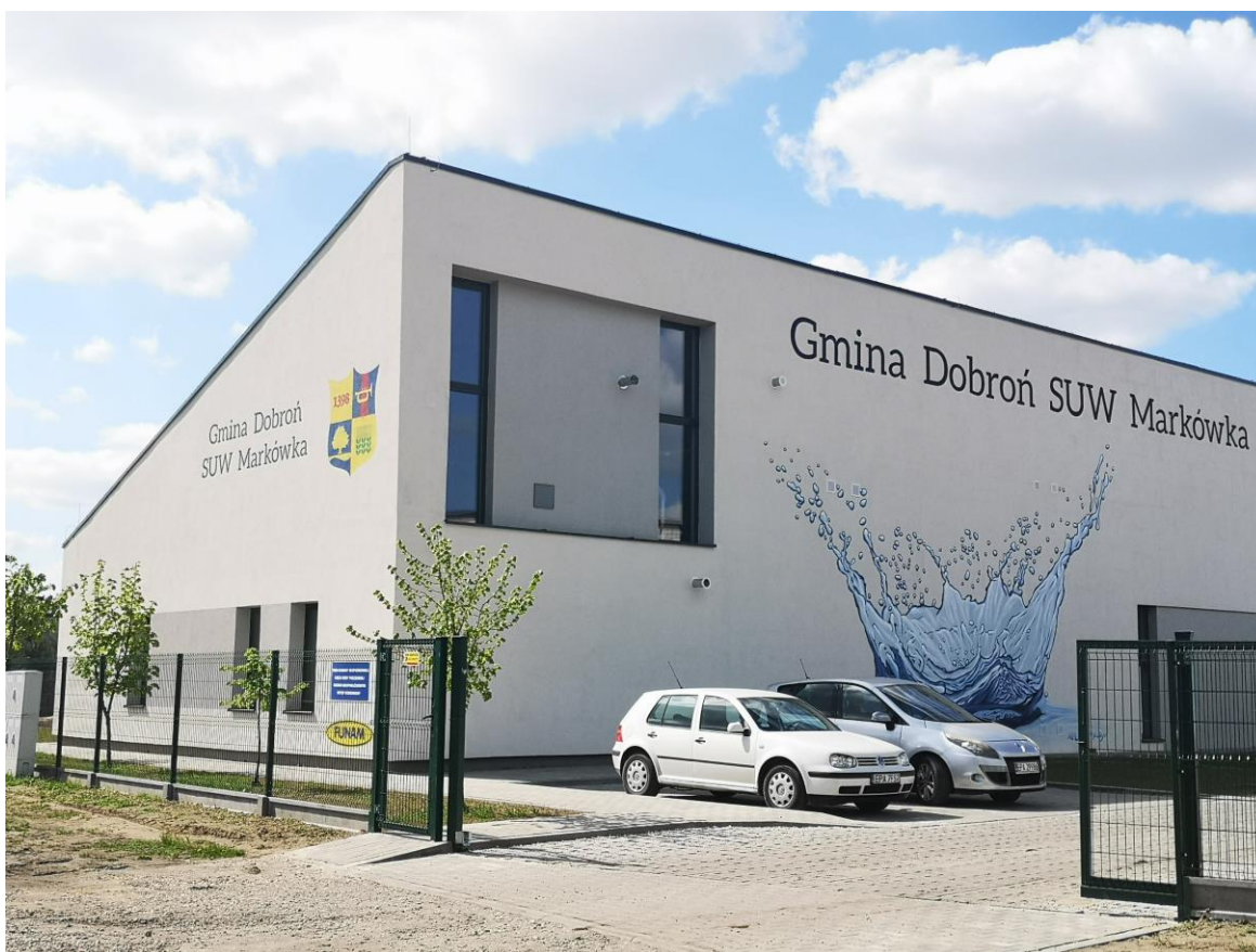
Źródło: zasoby własne, Nowy budynek Stacji Uzdatniania Wody w Markówce
