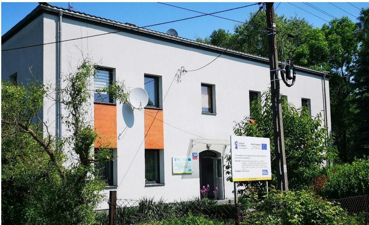
Źródło: zasoby własne, Budynek komunalny Markówka 50
