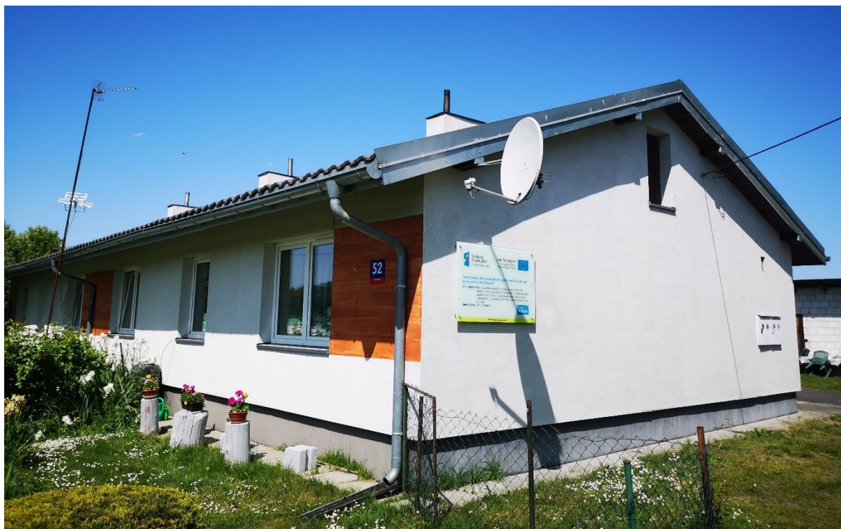
Źródło: zasoby własne, Budynek komunalny Markówka 52
